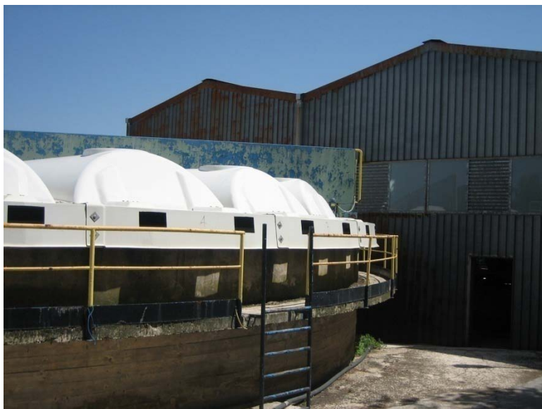
Copertura ispessitore statico
