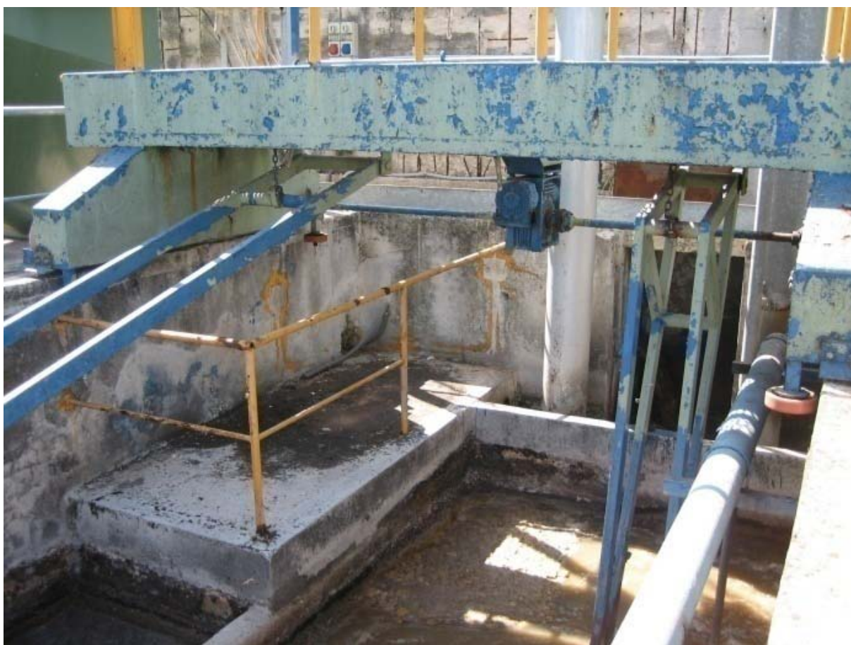
Ponte dissabbiatore esistente
